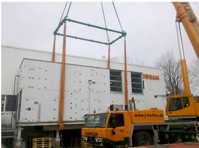
**Bildunterschrift:** Eine Hilfskonstruktion ermöglichte es, dass die Raumluftechnikanlage in einem Stück versetzt werden konnte. Die Alternative wäre eine zeitaufwendige Zerlegung gewesen. **Bildquelle:** Osram
