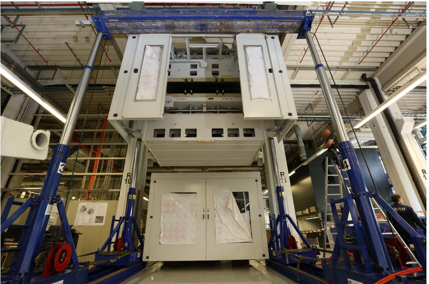
Die Geometrie des Hubgerüsts musste während des Hebens der oberen Presse permanent überwacht werden.
